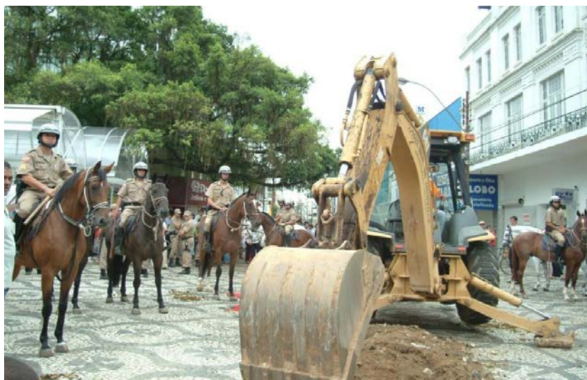
Figura 1 – Escavadeira destrói calçadão, protegida por policiais – 1.º/3/2004
