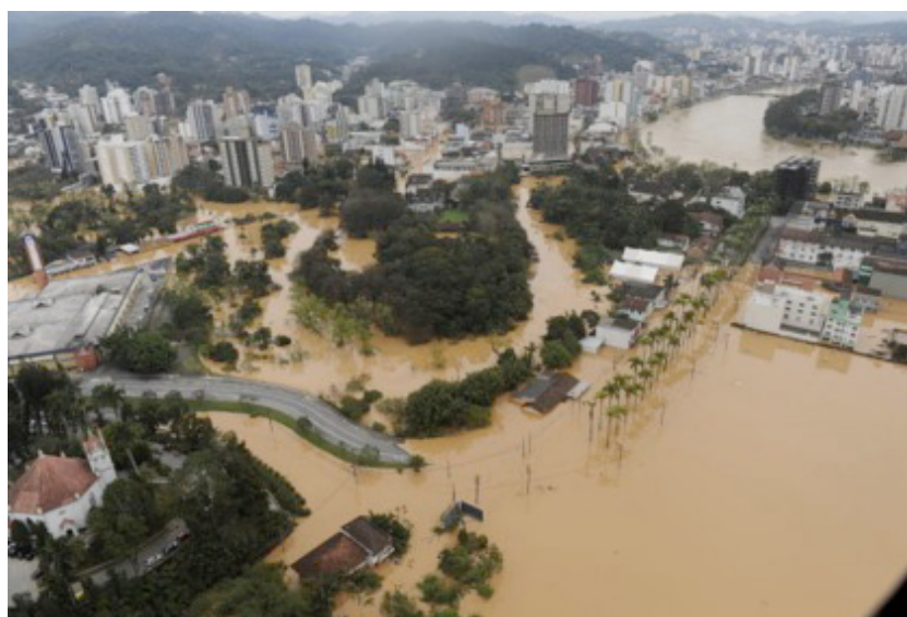
Figura 5 – Fotografia aérea da enchente de setembro de 2011 em Blumenau, última que atingiu a cota 12 do município, com pico de 12,80 m registrado às 12h do dia 9, de acordo com o Centro de Operação do Sistema de Alerta (CEOPS)
