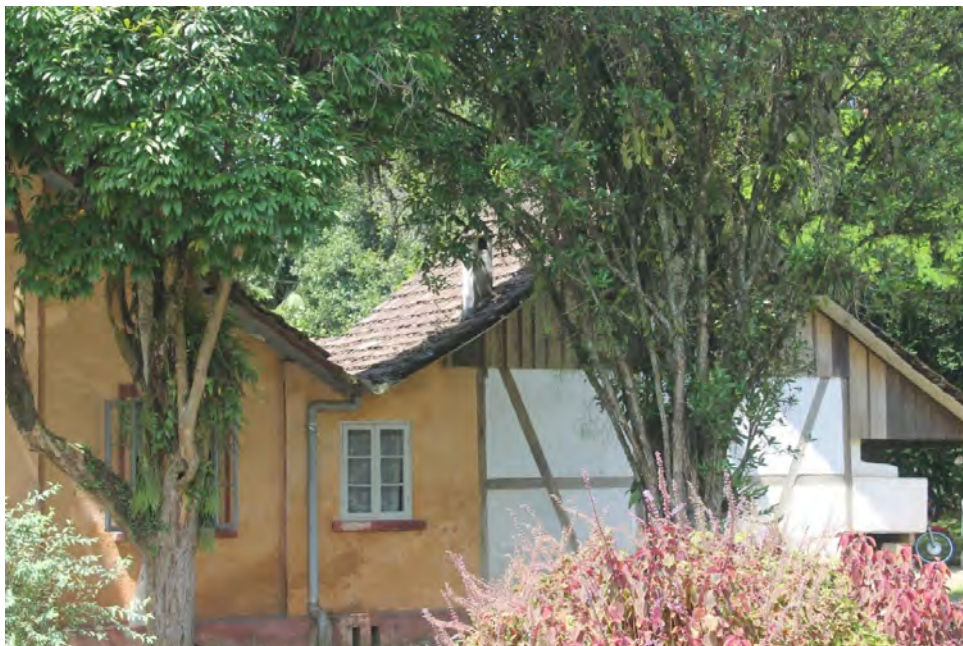
Figura 4 – Casa Krüger – a cor branca designa a técnica construtiva enxaimel, e a cor amarela, a técnica construtiva de tijolos autoportantes rebocados (Joinville – SC, 2014)
