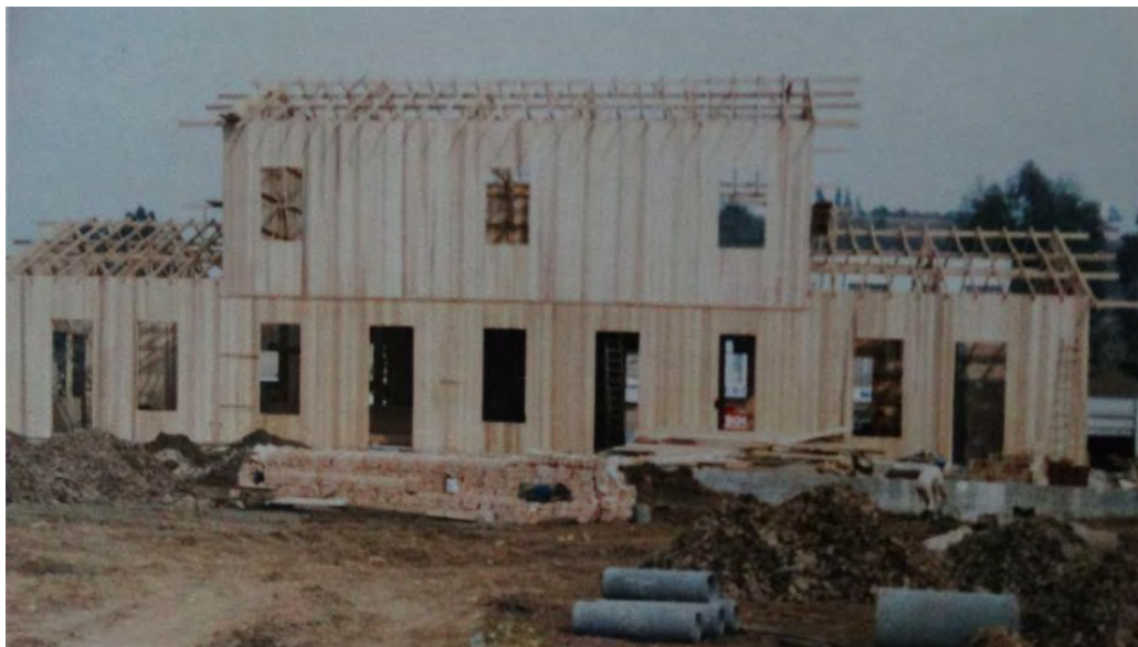
Figura 2 – Construção da sede própria do Museu do Contestado (1986)
