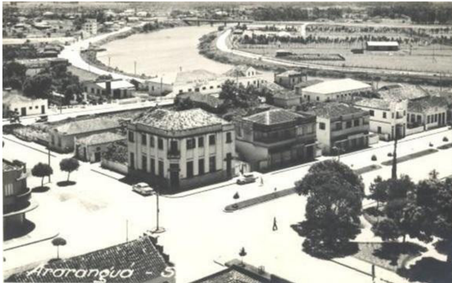
Figura 2 – Edificação do atual museu no centro da imagem (período estimado: décadas de 1950/60)
