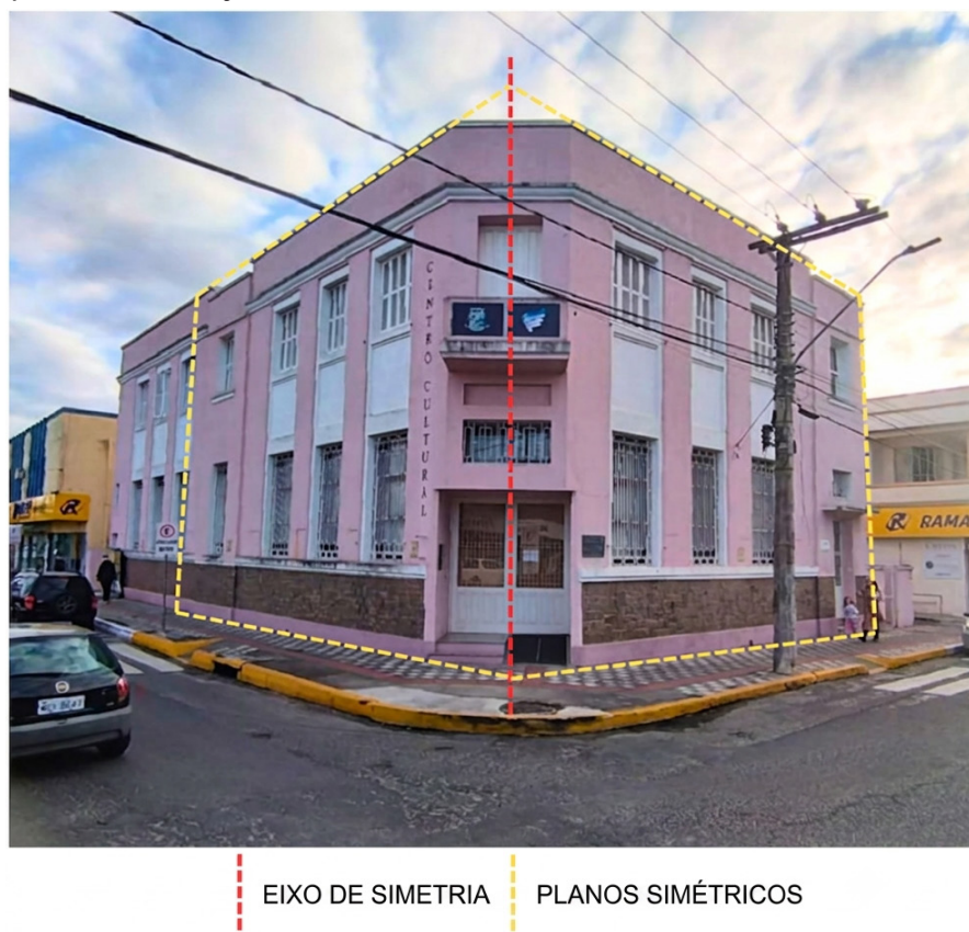
Figura 6 – Esquina da edificação em 2025, demonstrando o eixo de simetria da edificação original
