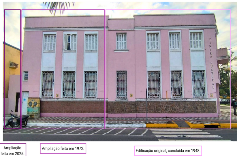
Figura 7 – Ampliações realizadas na edificação, vistas na fachada sudeste
