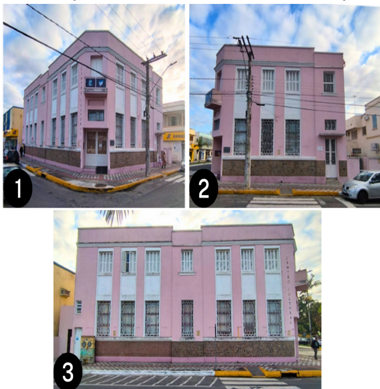
Figura 5 – Edificação do Museu de Araranguá em 2025: 1) esquina da edificação em 2025; 2) fachada nordeste da edificação em 2025; 3) fachada sudeste da edificação em 2025
