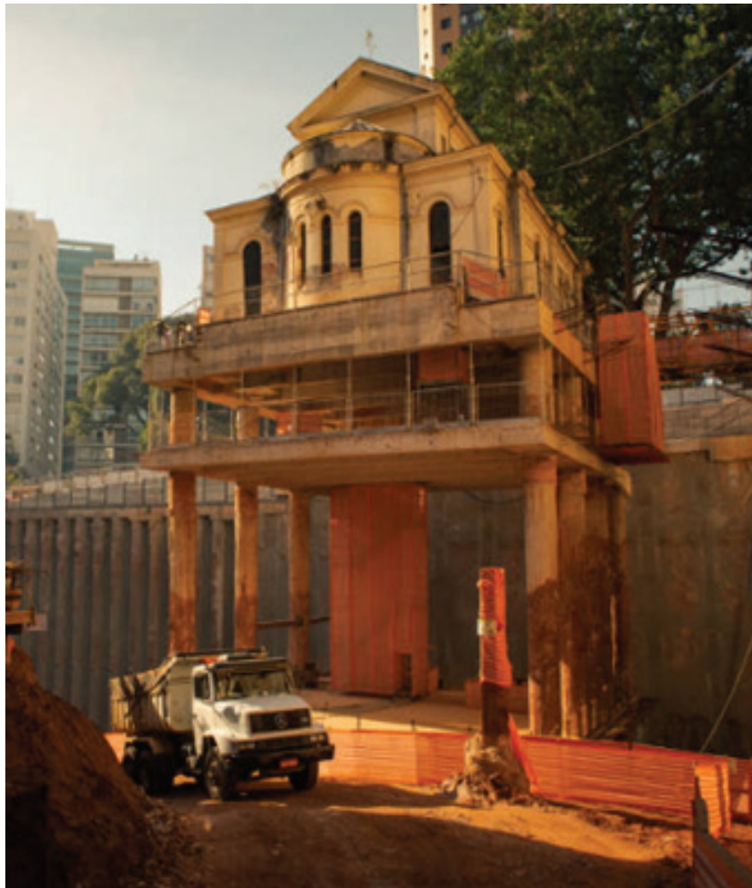
Figura 1 – Capela do Hospital Matarazzo “suspensa” para a construção dos subsolos
