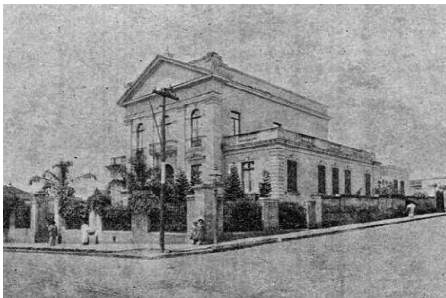
Figura 2 – Primeiro prédio do hospital, localizado na Rua Major Diogo, 200, Bixiga
