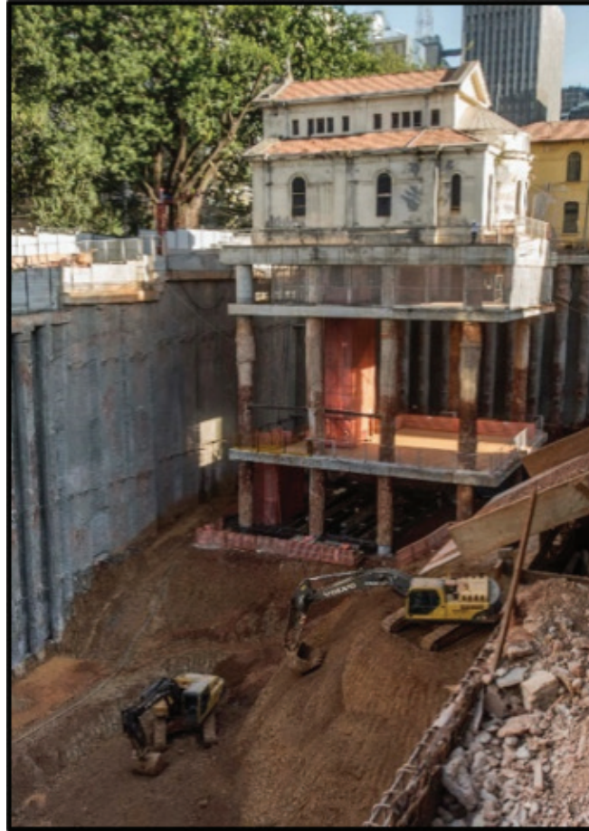
Figura 3 – Capela “suspensa” para a construção dos subsolos (visão lateral)
