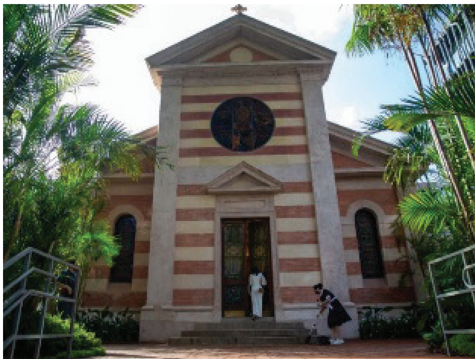
Figura 5 – Fachada da capela depois do restauro
