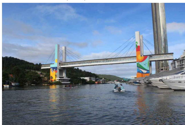
Figura 17 – Passarela do Rio Camboriú (2021)
