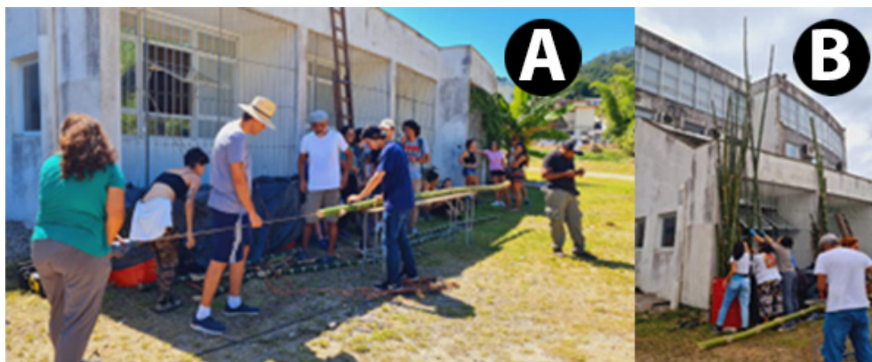
Figura 5 – Furação dos entrenós e tratamento dos bambus
