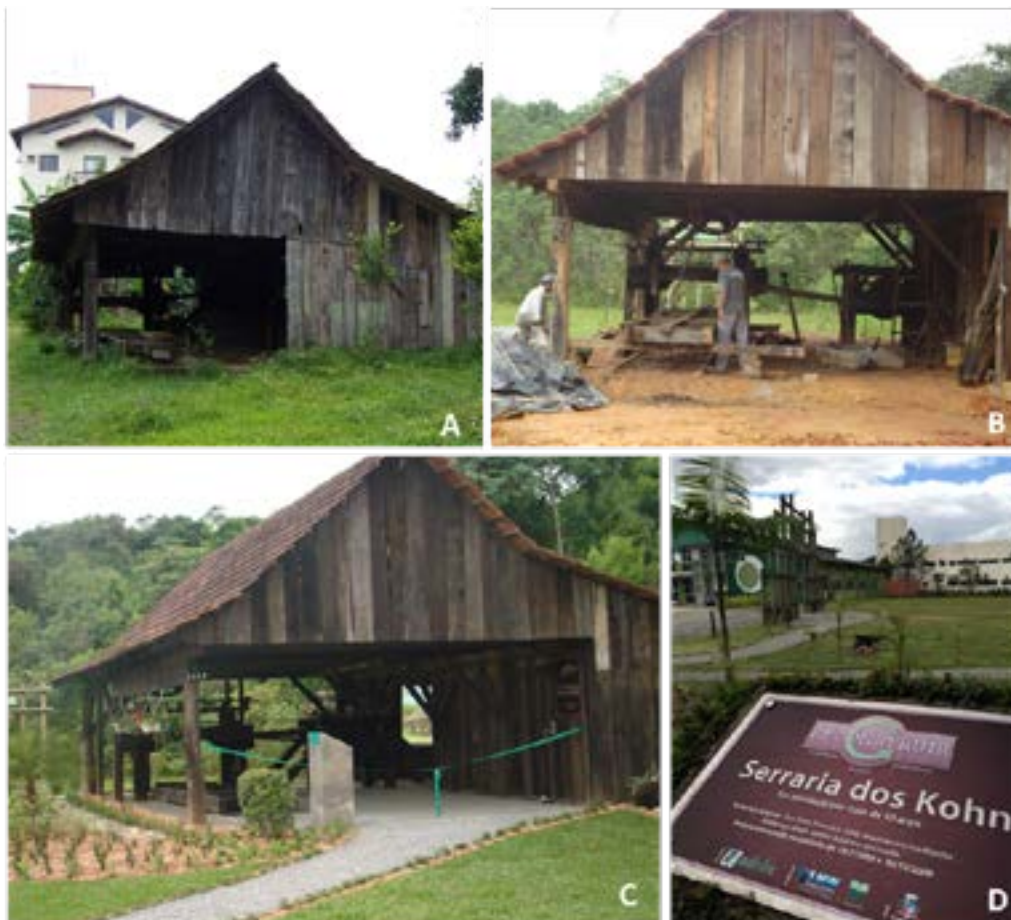
Figura 11 – Serraria dos Kohn. A: na sua localização original; B: durante a reconstrução no Jardim Botânico; C: no dia da inauguração no Jardim Botânico; D: placa da serraria. Fonte: primária.
