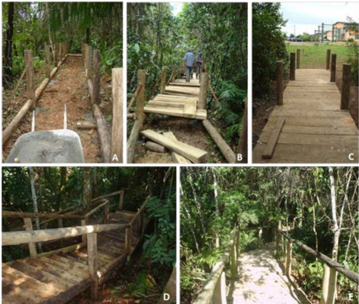
Figura 7 – Diversos estágios de construção da trilha suspensa no Jardim Botânico da Univille. Fonte: primária.
